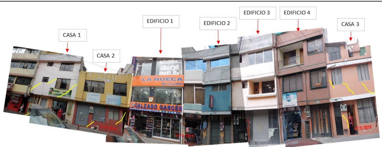
Foto No.19 Edificios se asientan y levantan a casas de menor peso
