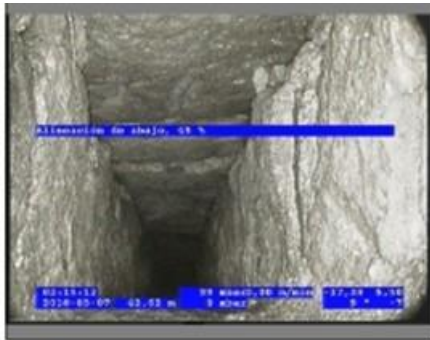
Foto: 6_12A 42,62m, Alineación de abajo, 45 % / Ninguna, dentro de los parámetros admisibles
