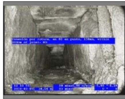
Foto: 6_10A 39,02m, Conexión por rotura, en 02 en punto, 150mm, within 200mm of joint: NO / Ninguna, dentro de los parámetros admisibles
