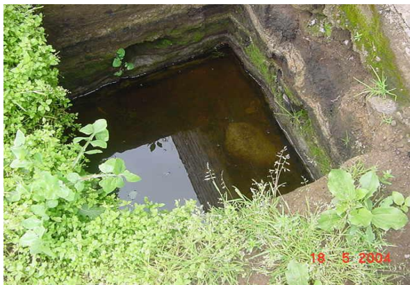
Foto No.1 Perforación para un plinto en sector Solanda, se presenta un material fluvio lacustre, el material arcilloso orgánico y nivel de agua superficial
