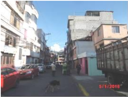
Foto No.22 Calle José Belda, presentan edificaciones de cuatro a cinco plantas
