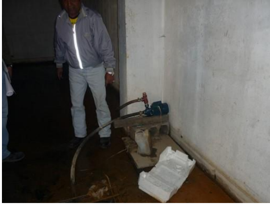
Foto No.7 Proceso de bombeo por nivel freático alto
